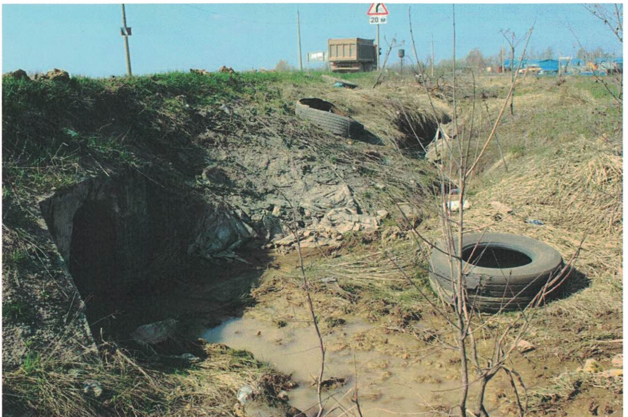
Фото 2. Место пересечения ручья б/н автомобильной дорогой местного значения.
